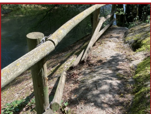
Barana en molt mal estat (travessar trencat, perillós)
