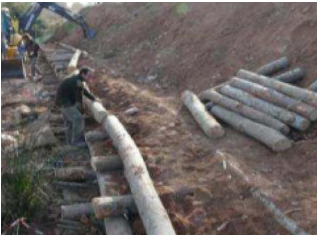
Entramat tipus Krainer: inici instal·lació
