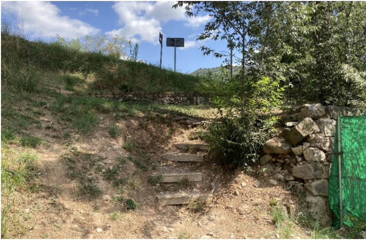
Mur i escaleres a consolidar (es veu com el mur està perdent la seva consistència i les escaleres estan perdent la seva base)
