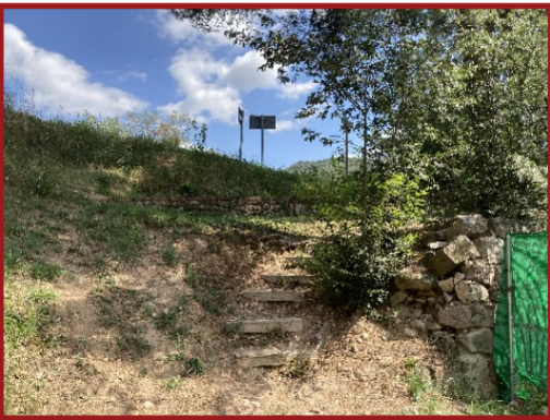
Mur de pedra que presenta un risc de esclavissada i tanca inadaptada
