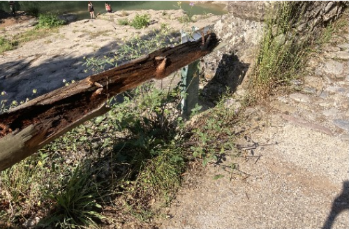
3 - Reemplaçament de la tanca podrida del pont del Pedret
