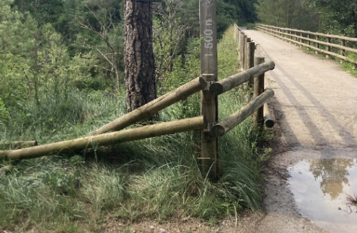
3 - Tanca defectuosa en la entrada del pont de la Peirola
