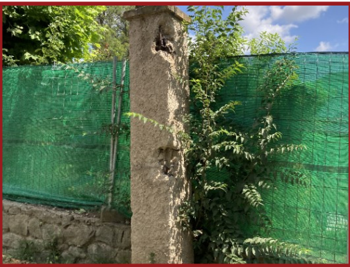
Element que marca l'entrada a la fàbrica en molt mal estat i tanca inadaptada
