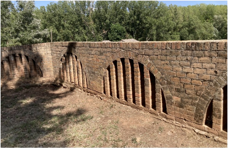
Detall del muret de tanca que es té que consolidar i reparar amb rejuntat
