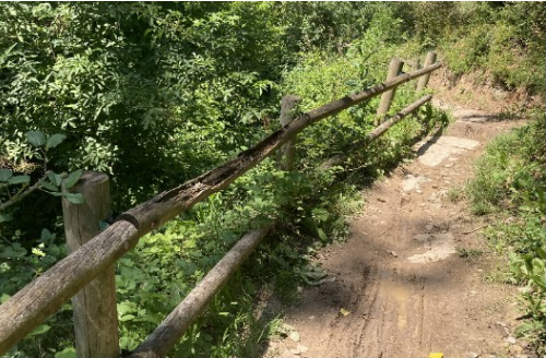
3 - Reemplaçar la part podrida de la tanca
